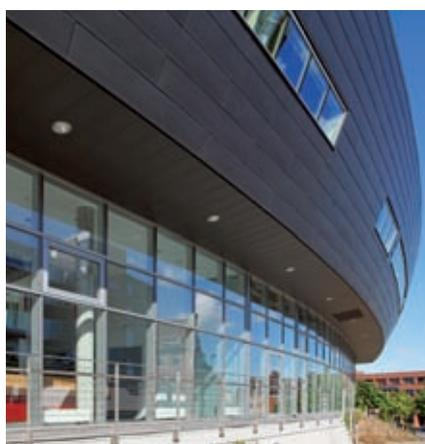
Die für die Fassade und die Unterdeckung verwendeten Flatlock-Profile ermöglichten ein flächenbündiges Erscheinungsbild. Durch die doppelte Krümmung der Fassade mussten die Profile individuell vor Ort verfalzt werden.
