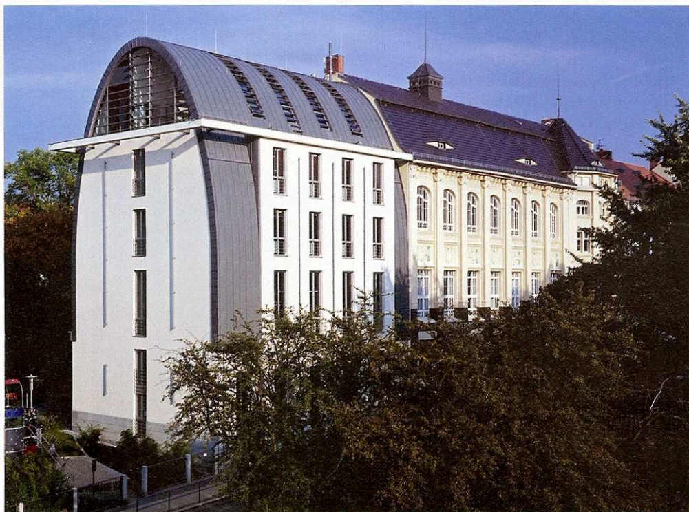
Der Erweiterungsbau setzt die Bauflucht des bestehenden Gebäudes fort. Bilder: VMZINC, Essen
