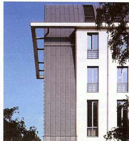
Das vorbewitterte, samtgraue Titanzink trug zur Verwirklichung des vom Architekten entwickelten Anspruchs bei.
